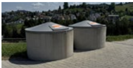
Halbunterflurbehälter Unter Bendlehn
