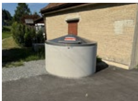
Halbunterflurbehälter Rickstrasse (Speicherschwendi)
