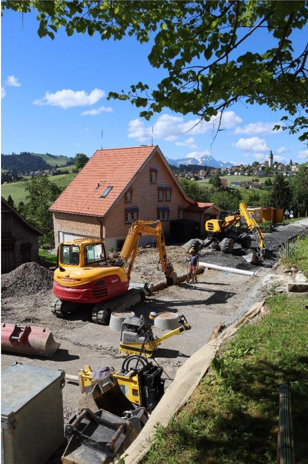
Anschliessend wurde der erste Teil der Foundationsschicht eingebaut und verdichtet. Das Ziel ist es ab Juli den Verkehr in die Oberen Kohlhalden wieder über den Dorfteil Speicher umzuleiten, so dass die nächsten Arbeiten in Richtung Speicherschwendi weitergeführt geführt werden können.
