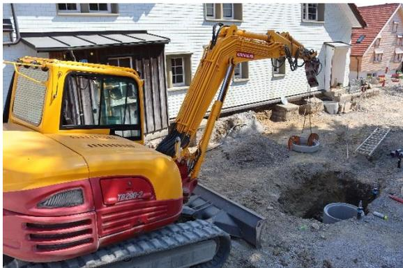
In einem nächsten Schritt werden die Entwässerungsleitungen in Richtung Speicherschwendi gegraben und verlegt.
