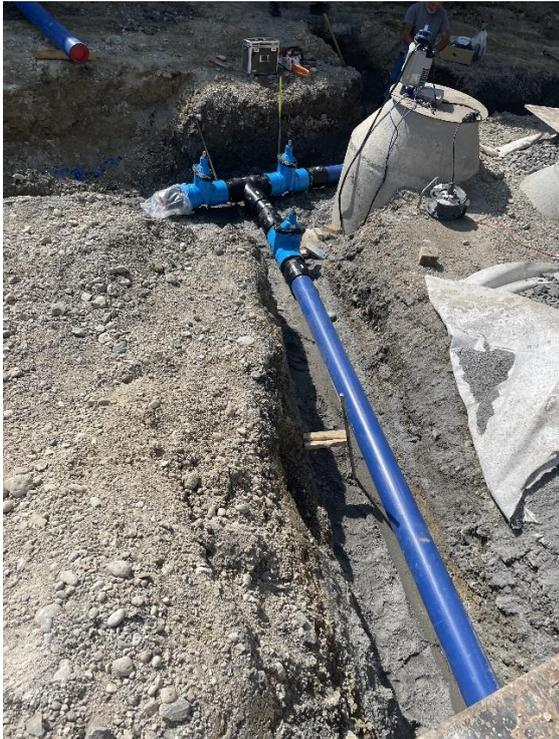
Die Grabarbeiten und die Sanitärarbeiten für die neue Wasserversorgungs-Transportleitung sind weiter vorangeschritten. So konnte die Leitung bis zur bestehenden Transportleitung in der Oberen Kohlhalden verlegt und für den Zusammenschluss vorbereitet werden.
