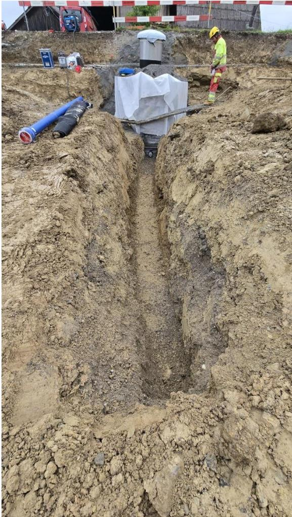
Der DRV konnte versetzt und die neuen Anschlussleitungen verlegt werden.
