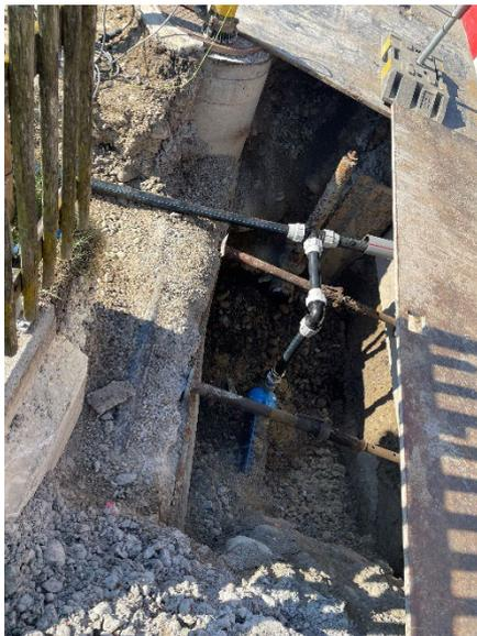
Dadurch konnte mit Grabarbeiten für die neue Versorgungsleitung begonnen werden. Diese wird trocken verlegt. Das bedeutet, dass ein gewisser Leitungsabschnitt eingebaut wird. In dem entsprechenden Abschnitt werden anschliessend eine Druckprobe und eine hygienische Probe entnommen. Bei positiven Ergebnissen wird der jeweilige Abschnitt von der Wasserversorgung freigegeben und anschliessend in Betrieb genommen.
