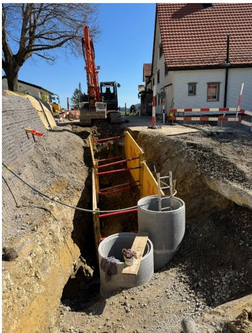
So konnten die Kontrollschächte der Meteor- und Schmutzwasserableitung in der Strasse versetzt werden. Die Schächte ragen rund 4 Meter tief in den Untergrund.
