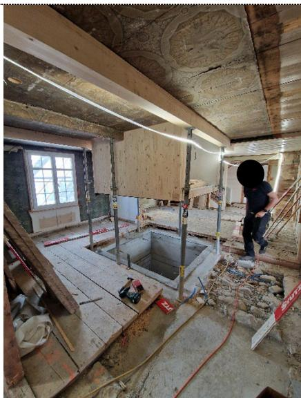
Im Erdgeschoss wird das Holzelement auf den vorbereiteten Betonsockel herabgelassen und fest verschraubt.
