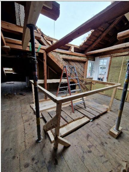
Kurz vor der Montage des Liftschachtes wird das Dach geöffnet.
