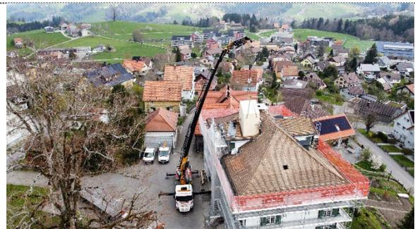
Der Liftschacht wird über Dach ins Gebäude eingefahren...
