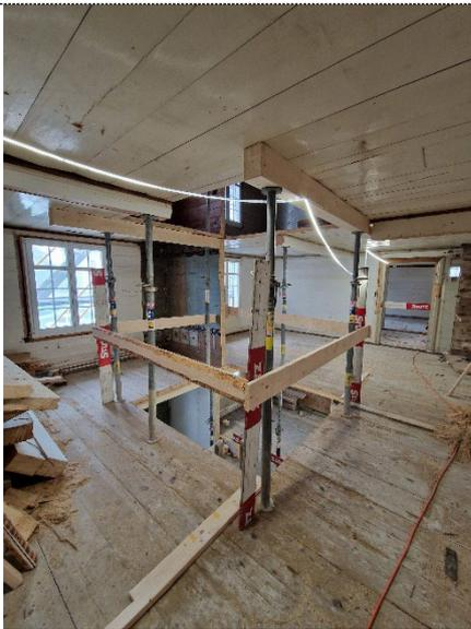
Die Durchbrüche durch alle Geschossdecken im Holzbau werden vorbereitet.
