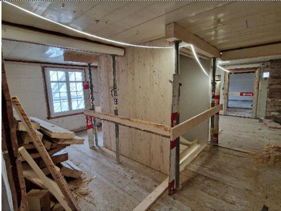
Der Liftschacht ist nun fix montiert, auf jedem Geschoss werden nun die Decken und Wände statisch mit dem Liftschacht verbunden.
