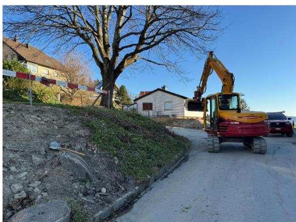
Im Bereich der Einmündung Obere Kohlhalden befindet sich eine Winterlinde. Der gegen die Strassen reichende Wurzelbereich musste für das geplante Mauerwerk abgetragen werden. Diese Abtragung konnte, aufgrund des während der Planungsphase erstellten Baumschutzkonzepts, mit einem Baumpflege-Spezialisten begleitet und schrittweise vorgenommen werden. Ausserdem wurde eine Bewässerungsanlage installiert.
