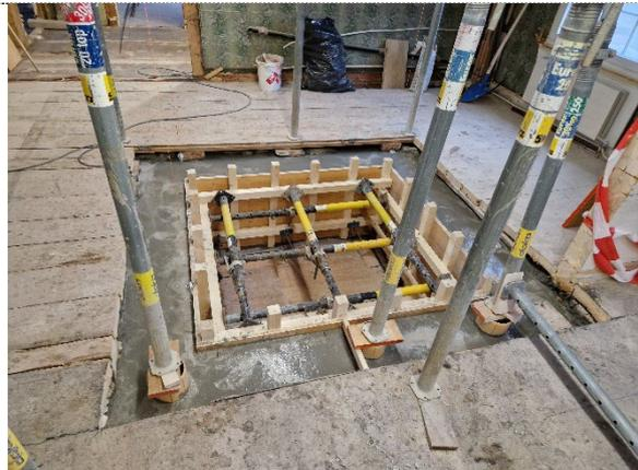
Nach dem Ausschalen des Betonkranzes wird bereits eine erste Deckendurchdringung des späteren Liftschachtes erkennbar.
