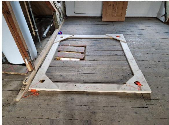
.... wird das Liftschacht-Innenmass durch alle Decken bis zum Erdgeschoss und via Kernbohrungen durch die Gewölbedecke bis ins Untergeschoss heruntergelotet. Der eigentliche Bau des Liftschachtes beginnt in der Decke über dem Untergeschoss.
