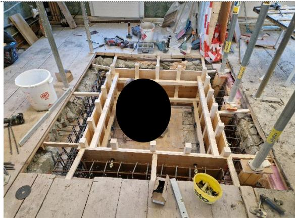
Nach dem Betonieren des Betonkranzes ist die Gewölbedecke wieder gesichert und stabil.
