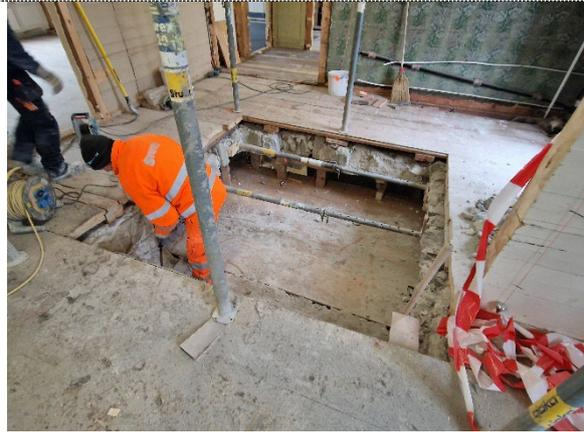
In der Ebene der Gewölbedecke wird ein Kranz aus Beton gebildet, der die Kräfte der fehlenden Gewölbedecke um den Liftschacht herum ausgleicht und überträgt.
