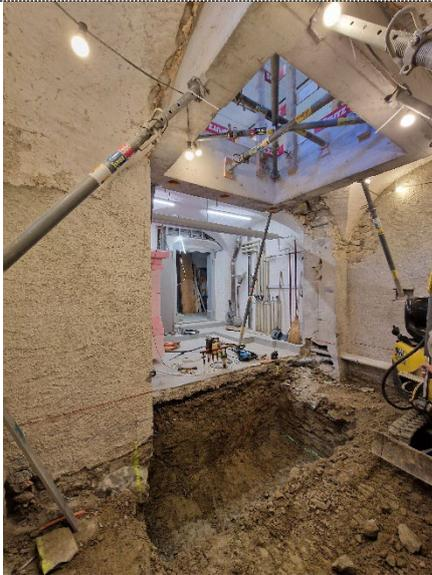
Im nächsten Schritt wird der Aushub im Untergeschoss für die Vertiefung der Liftunterfahrt erstellt.
