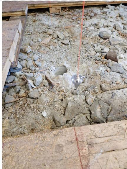
Gewölbedecken sind selbsttragende, bogenförmige Deckenkonstruktionen aus Natursteinen, ohne eine Armierung und ohne Stützen. Beim Öffnen solcher Decken lässt die Stabilität nach und die Decken werden instabil. Mit grösster Vorsicht und statischen Sicherheitsmassnahmen wird die Gewölbedecke über dem Untergeschoss geöffnet.
