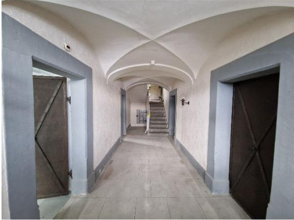
Sämtliches Mobiliar wurde entfernt und alle Einbauten rückgebaut.
