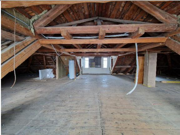
Nach dem Rückbau der Dachzimmer zeigt sich der nackte Dachstuhl mit der eindrucklichen Zimmermannskonstruktion.
