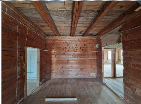
.... auffallend nach dem Rückbau der abgehängten Decken sind in diesem Geschoss die grossen Raumhöhen und die ursprünglich durchgehenden Räume auf der Südseite.
