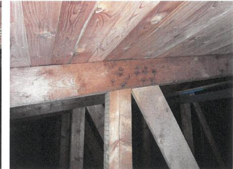
Die Dachkonstruktion über dem Schulhaus weist eine ähnliche Tragstruktur wie die Turnhalle auf. Die Nagelträger sind in sehr gutem Zustand. Die Schalung über den Fachwerken weist keine Wasserläufe auf und ist optisch in einem sehr guten Zustand.
