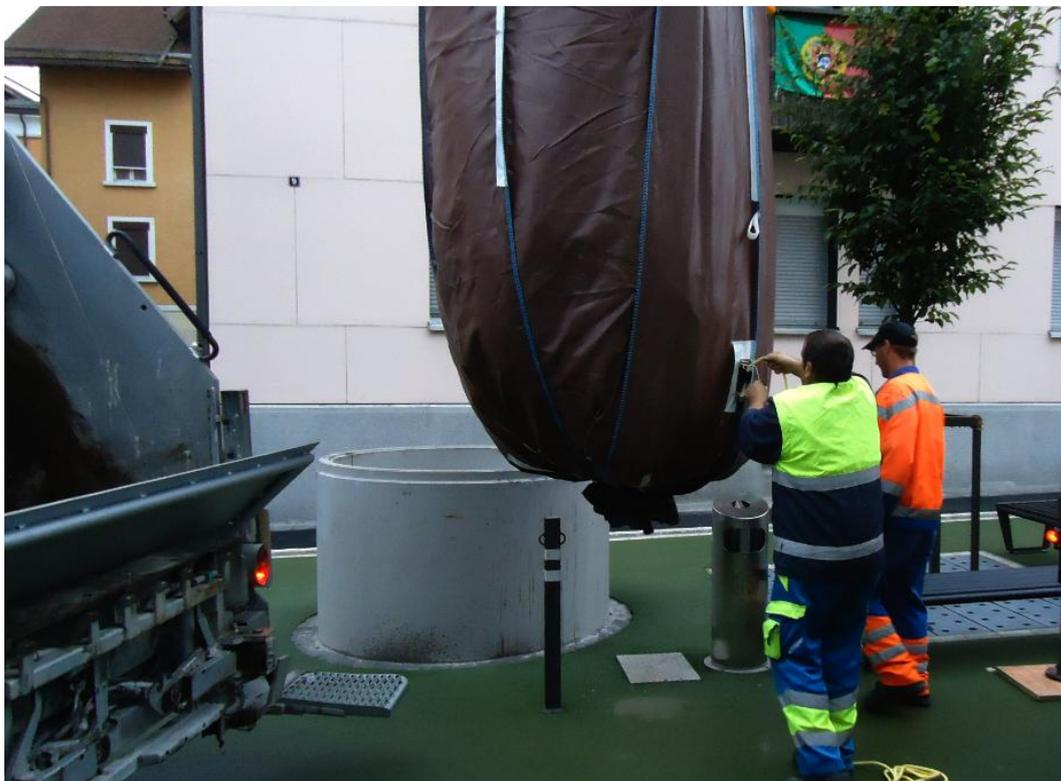
Das Zugseil wird von der Arretierung gelöst.
