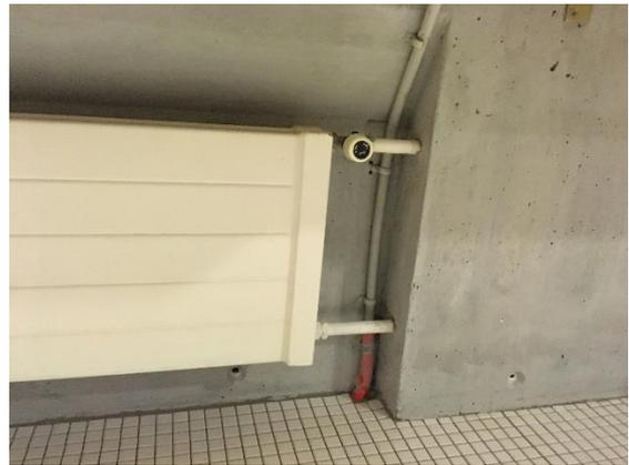
Abbildung 23: bestehende Thermostatventile
