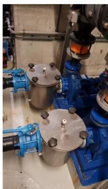
**Abbildung 42:** Filterpumpen mit Vorfiltersieben
