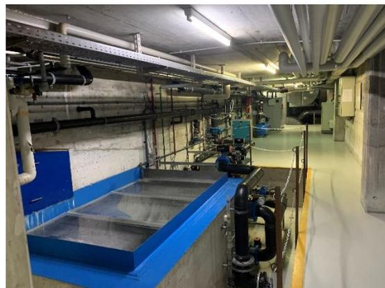
Abbildung 39: Bestand offener Anschwemmfilter
