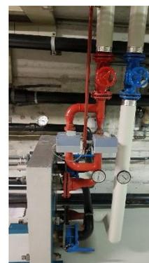
**Abbildung 44:** Plattenwärmetauscher
