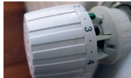
Thermostatventile ermöglichen die Temperatur den Bedürfnissen entsprechend in verschiedenen Räumen unterschiedlich zu regeln.
