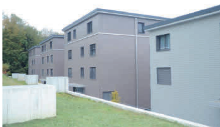
Hier im Haus 5 der neuen Wohnüberbauung im Quartier Halden wird das Kompetenzzentrum untergebracht.
